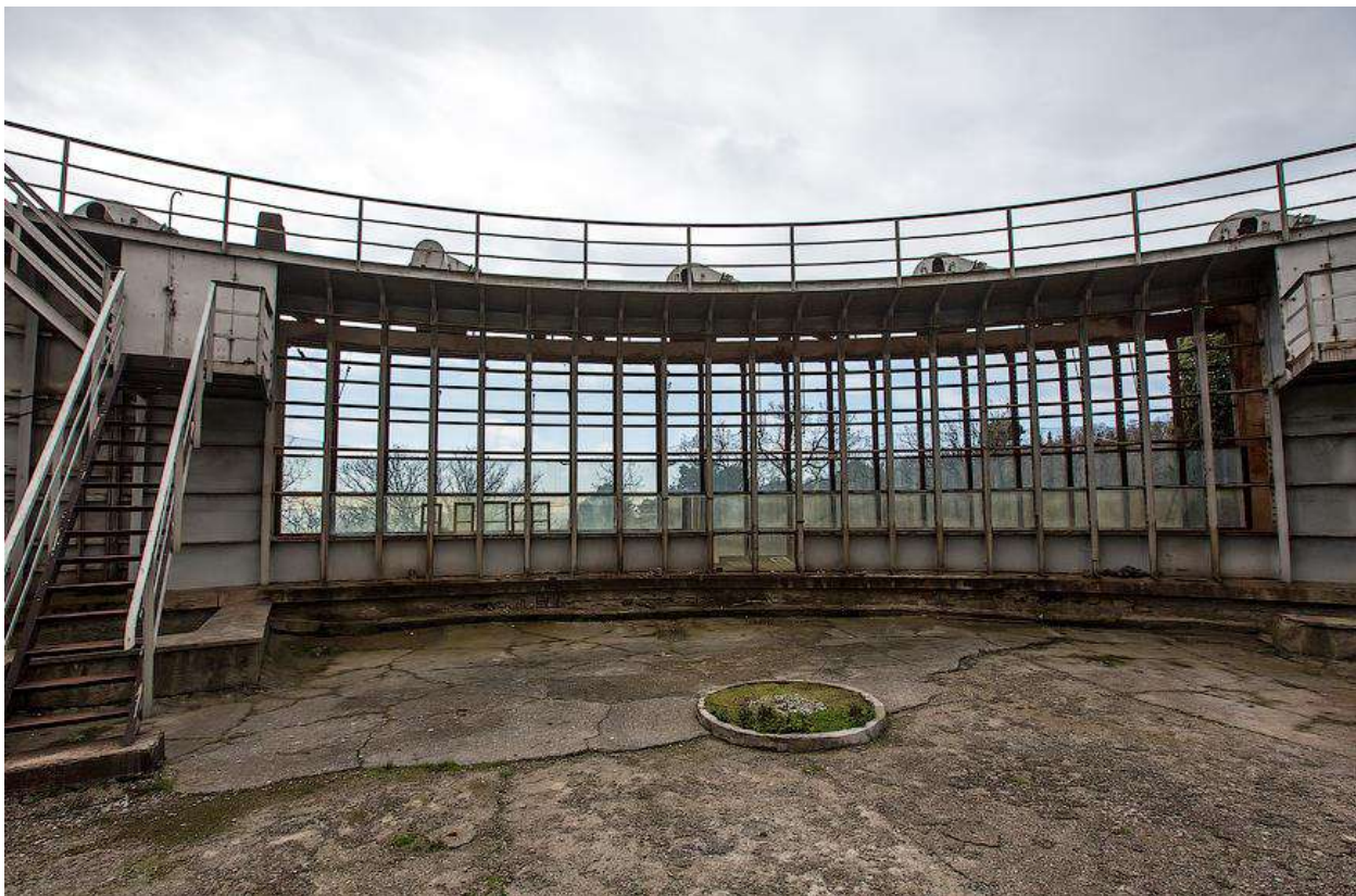
Вид на бассейн изнутри, от входа в башенку. Сейчас проёмы зияют пустотой, а когда-то были закрыты толстыми стёклами, часть из которых ещё стоит на своих местах
